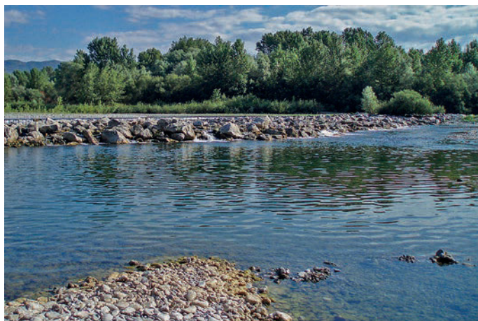
Sbarramento sul Fiume Magra (Foto L. Ciuffardi)
