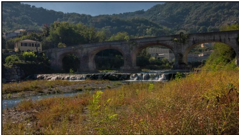
Fig. 2. Il Ponte Vecchio di Carasco; è possibile osservare la briglia alla base del ponte. - The Ponte Vecchio bridge (Carasco); it is possible to observe the weir under the bridge.
